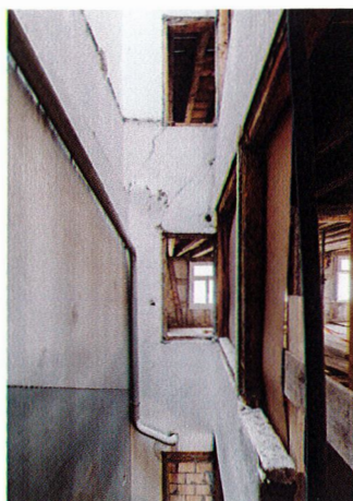
Ein Lichthof spendet Licht vom Dach in die Korridore und bis ins Erdgeschoss.
