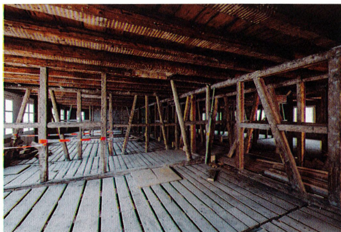
Das Gebäude wurde bis auf die Grundstruktur zurückgebaut - historische Ausstattung war auf Grund der zahlreichen baulichen und Nutzungsänderungen kaum vorhanden.
